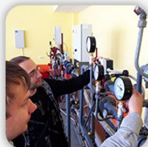
Теплоснабжение и теплотехническое оборудование
